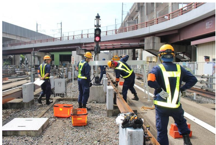
案内軌条復旧訓練
