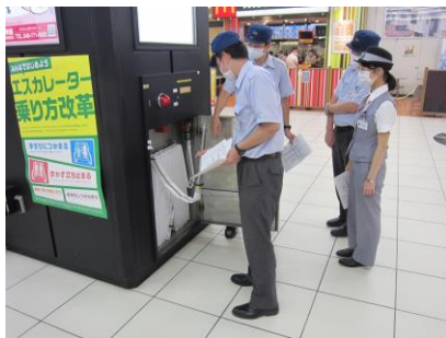
屋内消火栓の確認
